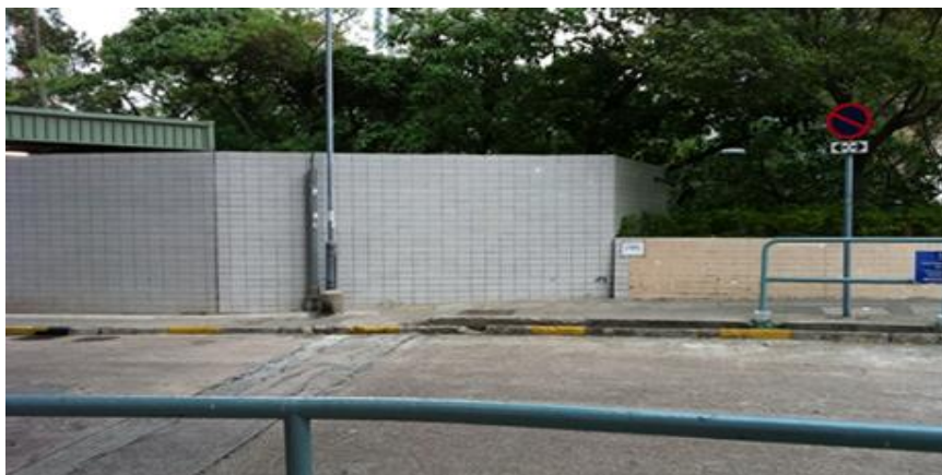
圖1 從防鼠的角度來看，花牀緊貼垃圾收集站等設施是典型的設計失誤
