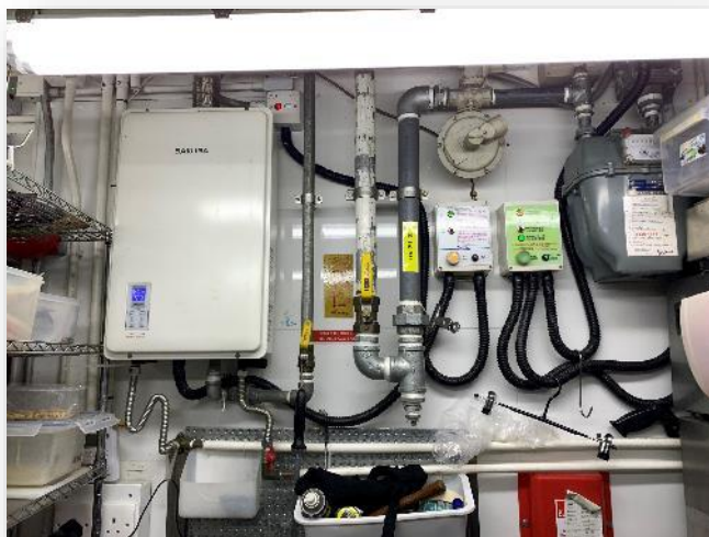
典型排氣系統聯鎖裝置及顯示燈
