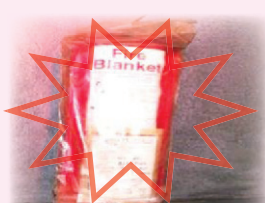
滅火氈密封在膠袋內， 火警時不能立刻使用
