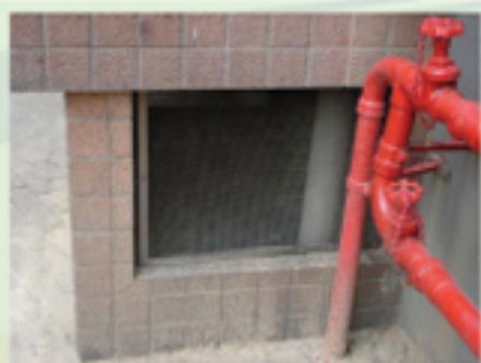
圖6.16(左)及圖6.17(右) 裝上鐵絲網的通風氣窗
