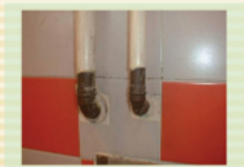
圖6.19 喉管穿過牆壁的地方用水泥密封
