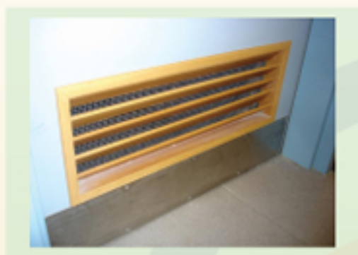
圖6.16(左)及圖6.17(右) 裝上鐵絲網的通風氣窗
