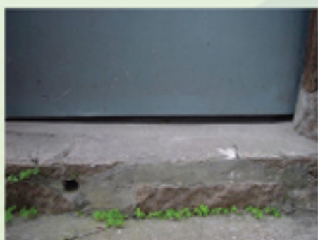
圖6.13(左) 門腳離地的空隙如超過6毫米，老鼠便能通過
