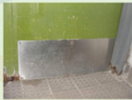
圖6.14(右) 在門腳裝上踢板收窄縫隙
