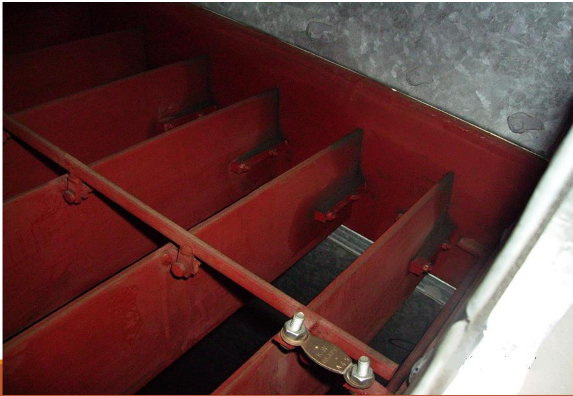
5.6) 空气过滤器(Filter) 须用不易燃物料制成
