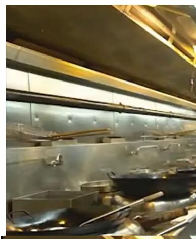
食物配製地方內所有煮食設備(例如爐灶、燒烤爐、油炸鍋及烤爐)上方均須設置金屬抽油煙機，與氣槽妥為連接，而氣槽則須配有足夠輸氣量的抽氣扇。廢氣應先流經濾油器，倘有規定，則再流經空氣污染控制設備，例如灑水器及靜電沉澱器，然後排到戶外。
