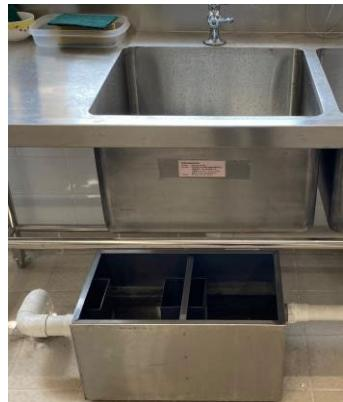
必須設置數量充足的隔油池，把污水中的油脂分隔出來，以防油脂流入排水渠或污水渠。
