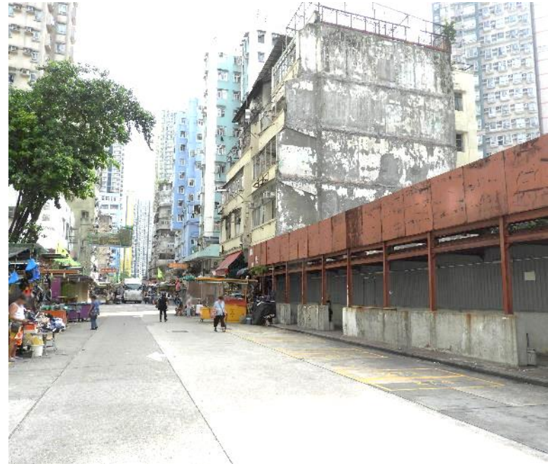
向順寧道 Facing Shun Ning Road
