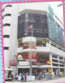
一九八四年位於設施完善的新一區市政大廈內的香港仔街市落成。前市政局便以此作為日後街市建設計劃的藍本。
