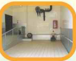
於街市垃圾收集站重鋪地磚、牆磚及翻新圍欄
