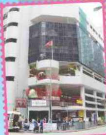
一九八四年位於被填完舊新區市政大廈內的香港仔街市落成。前市政局便以此作為日後街市建設計劃的藍本。
