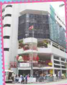
一九八四年位於設備完善新市政大廈內的香港仔街市落成。前市政局便以此作為日後街市建設計劃的藍本。
