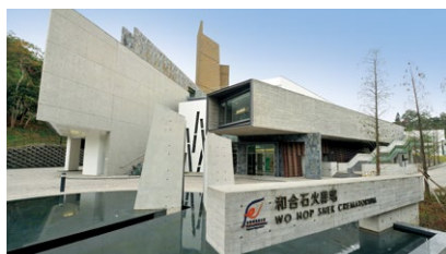
Wo Hop Shek Crematorium 15 Kiu Tau Road, Wo Hop Shek, Fanling, N.T. Tel: 2675 5200
